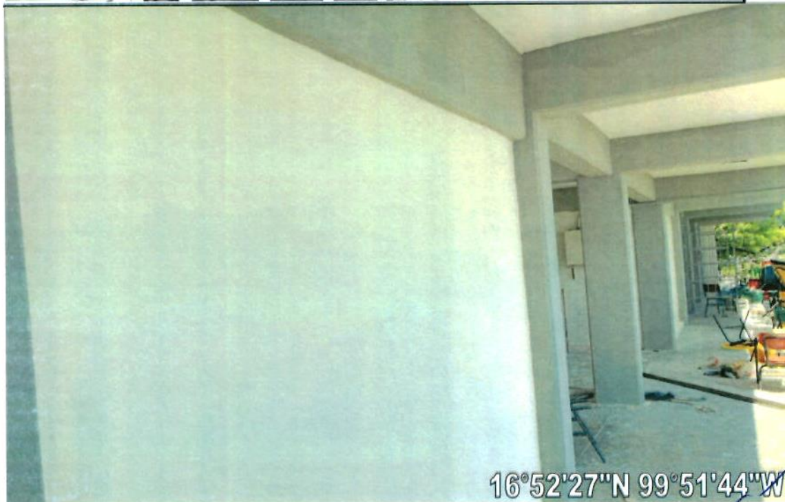
FOTO DE PROCESO DE OBRA
