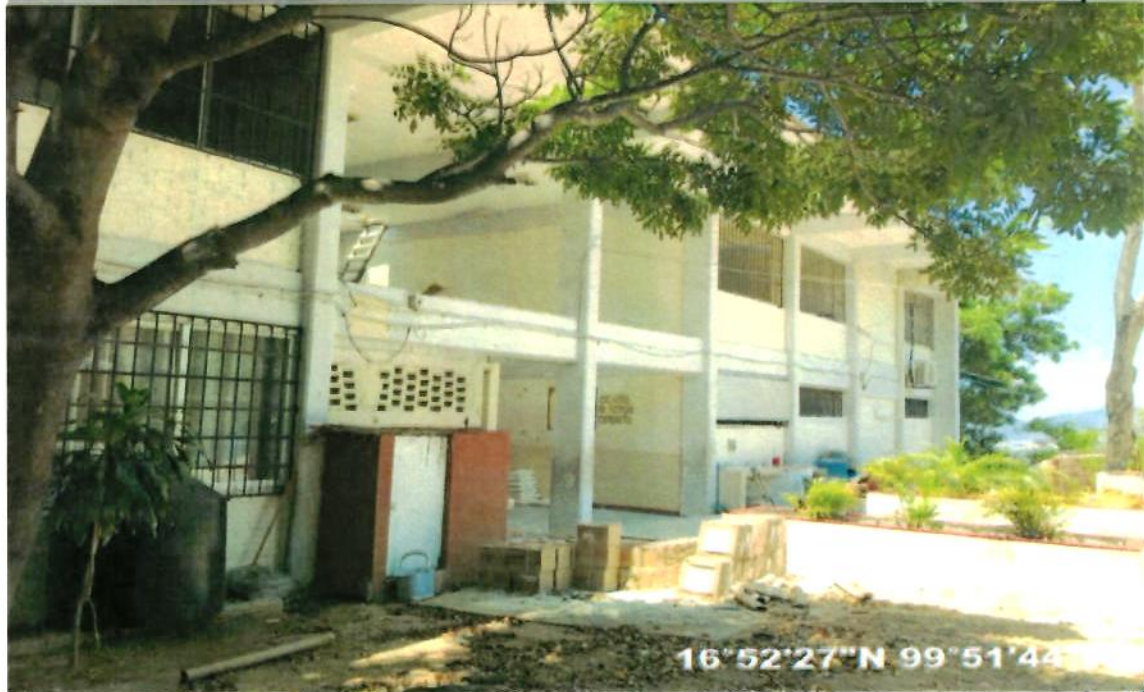
FOTO DE INICIO DE OBRA
