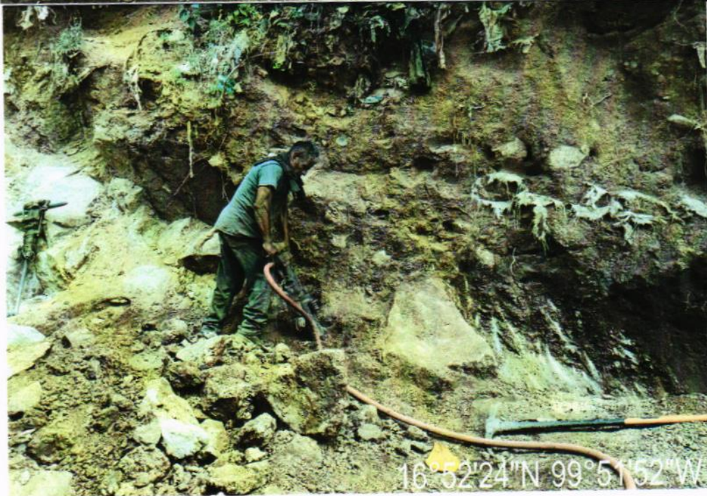
FOTO DE INICIO DE OBRA
