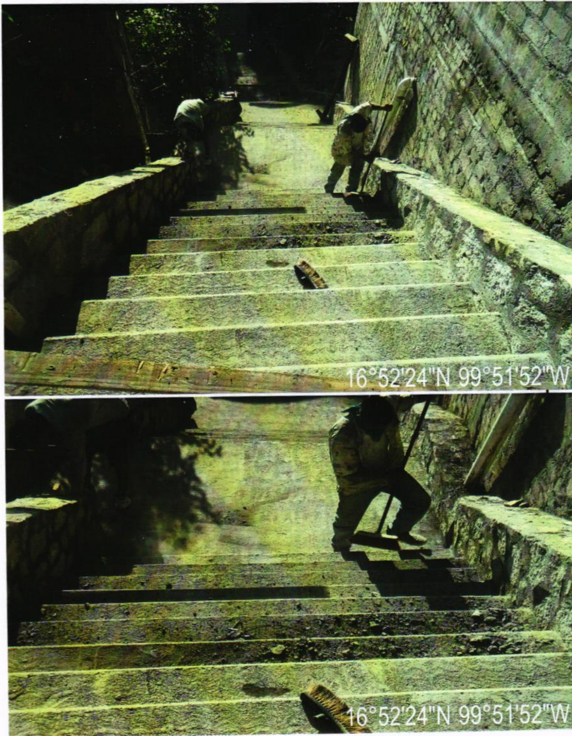
FOTO DE TERMINACION DE OBRA
