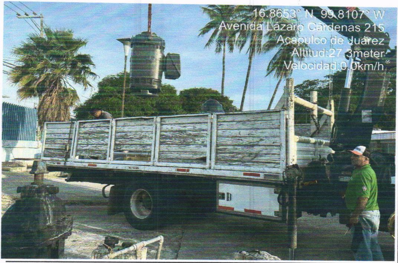
FOTO DE PROCESO DE OBRA
