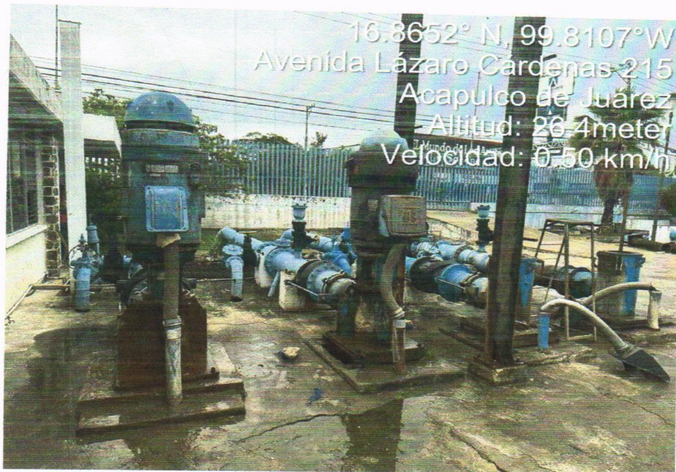
FOTO DE INICIO DE OBRA
