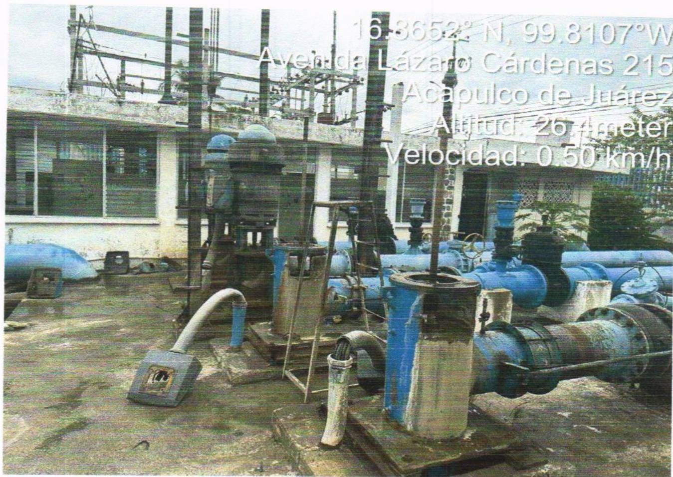
FOTO DE INICIO DE OBRA
