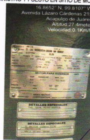
SUMINISTRO Y PUESTO EN SITIO DE MOTOR 400 HP
