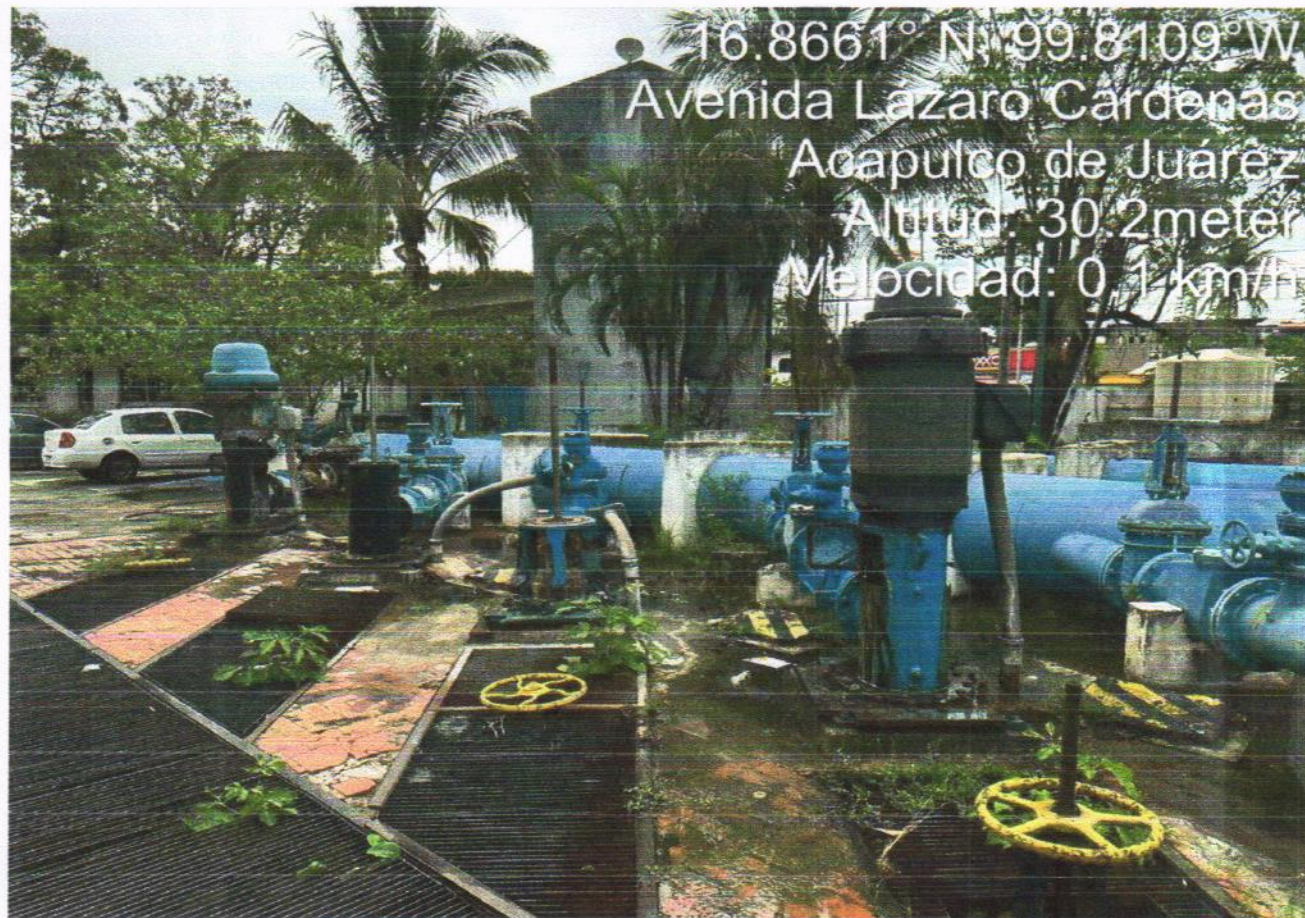
FOTO DE INICIO DE OBRA
