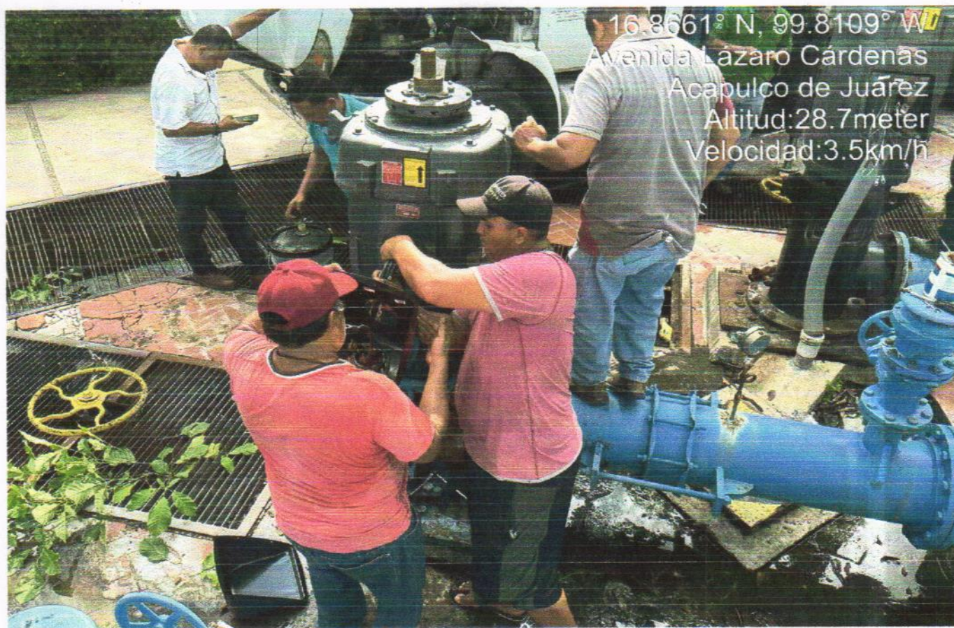
FOTO DE PROCESO DE OBRA
