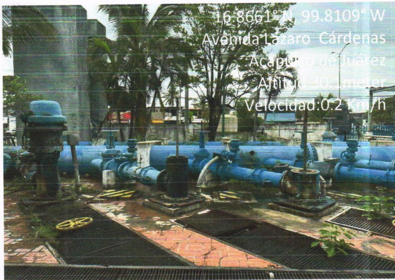
FOTO DE INICIO DE OBRA
