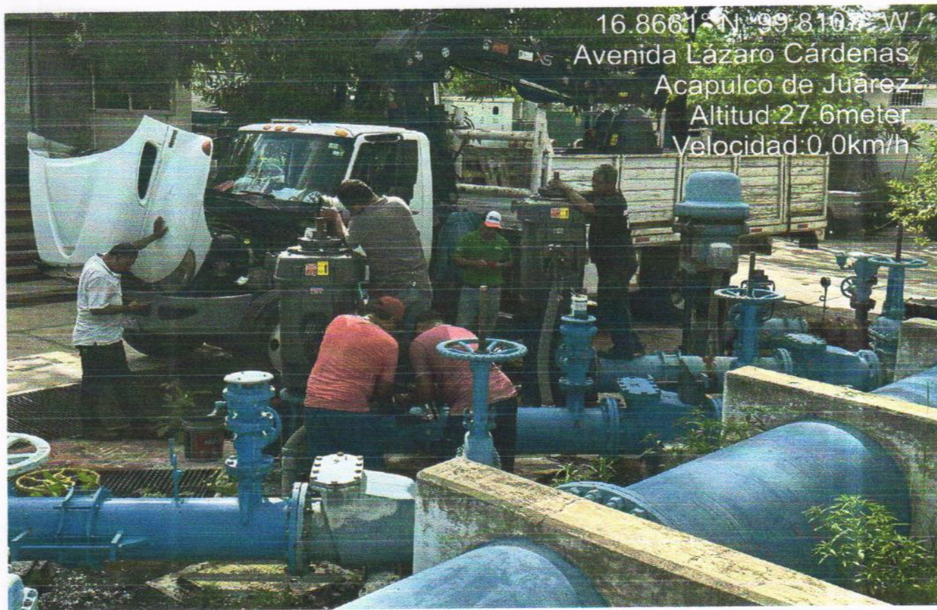
FOTO DE INICIO DE OBRA
