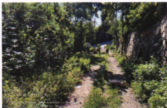
3-0073 TRAZO Y NIVELACION TOPOGRAFICA
