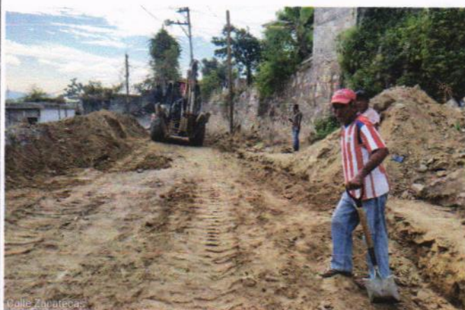
APERTURA EN CAJA POR MEDIOS MECÁNICOS
