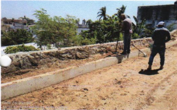
32-0466 AFINE Y COMPACTACION EN BANQUETAS, ANDADORES Y PLAZAS, A MANO, INCLUYE: ACARREOS DE MATERIAL EN 1ra. ESTACION. 16.42M2
