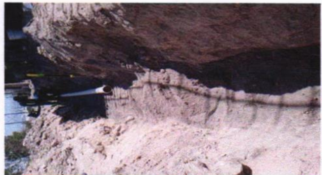
5-0102 CAMA DE ARENA PARA INSTALACION DE TUBERIA, INCLUYE: ACOSTILLADO, ACARREO DE MATERIAL EN 1ra. ESTACION, MATERIAL Y MANO DE OBRA.
