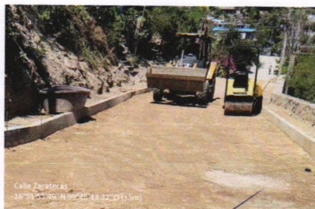
FORMACIÓN DE BASE DE 20CM DE ESPESOR
