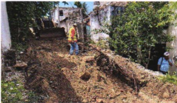
T-DES* TALA Y DESENRAÍCE DE ÁRBOL DE HASTA 45 CMS. DE DIÁMETRO, INCLUYE: EQUIPO Y HERRAMIENTA Y MANO DE OBRA.
