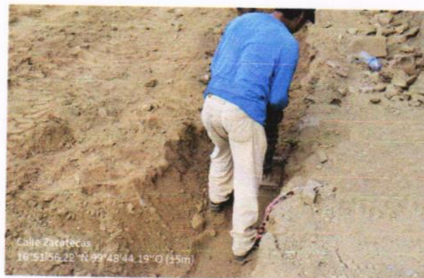
RELLENO DE MATERIAL INERTE DE BANCO
