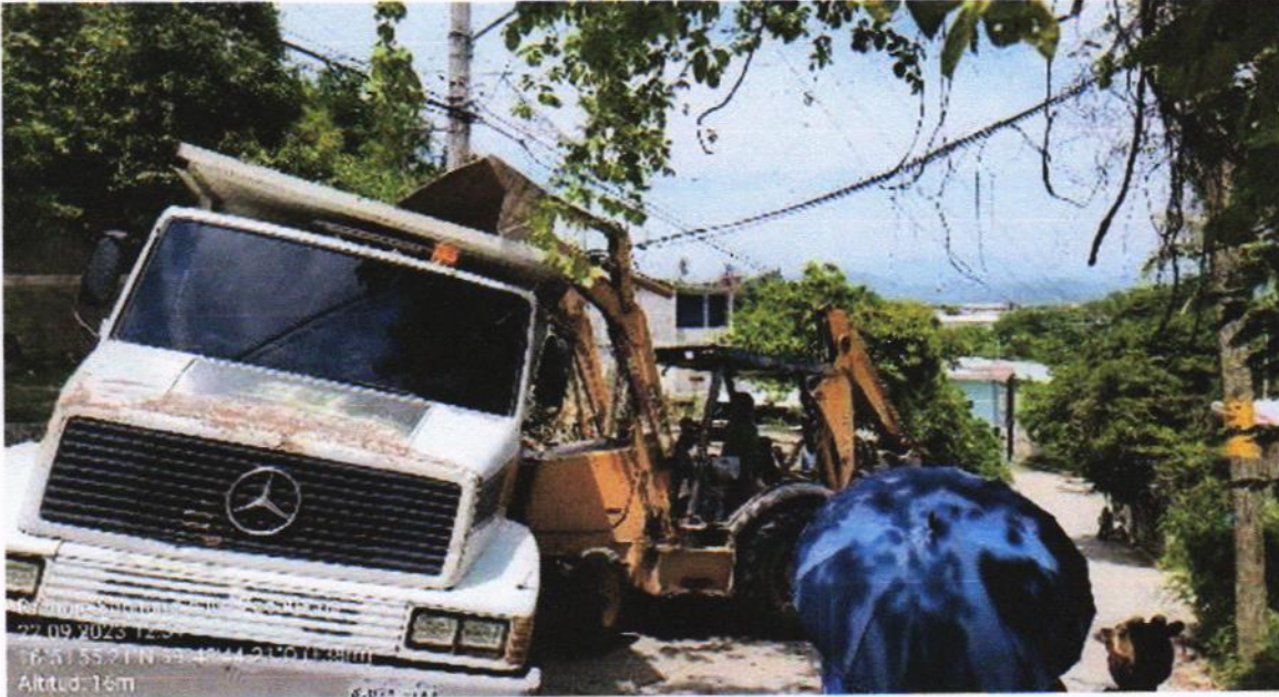
CARGA MECANICA Y ACARREO A TIRO LIBRE EN CAMION DE VOLTEO (6 M3) DE MATERIAL PRODUCTO DE EXCAVACION Y/O DEMOLICION (12 KM)
