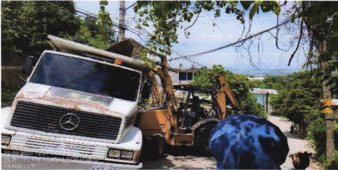
CARGA MECANICA Y ACARREO A TIRO LIBRE EN CAMION DE VOLTEO (6 M3) DE MATERIAL PRODUCTO DE EXCAVACION Y/O DEMOLICION (12 KM)
