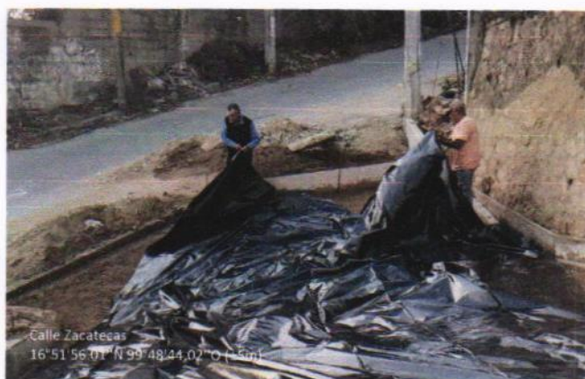
SUMINISTRO Y COLOCACIÓN DE MEMBRANA DE POLIETILENO
