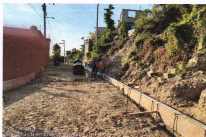
GUARNICIÓN DE CONCRETO F'C=200 KG/CM2
