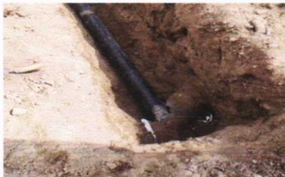
SUM-01 SUMINISTRO Y COLOCACION DE TUBERIA
