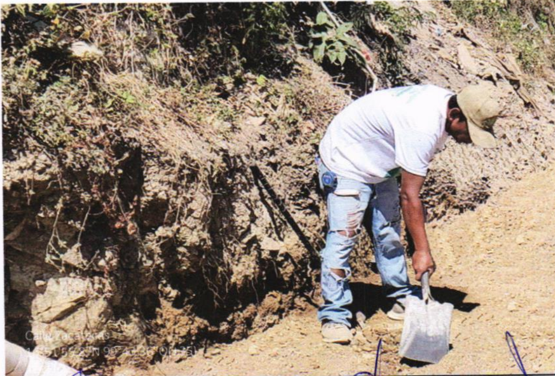
4-0079 EXCAVACION A MANO EN CEPAS DE 0.00 A 2.00 MTS. DE PROFUNDIDAD EN MATERIAL TIPO II, INCLUYE AFINDE DE TALUD Y FONDO.
