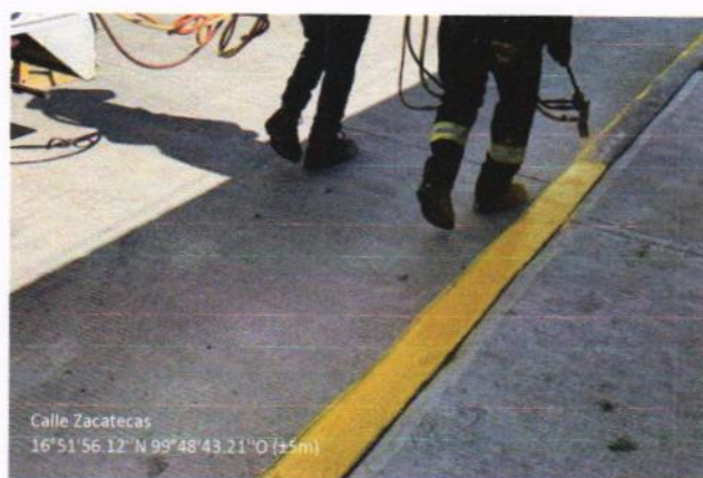
PINTURA DE ESMALTE COLOR AMARILLO EN GUARNICIONES
