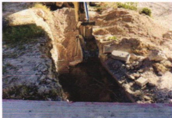
EX-MAT2A EXCAVACION POR MEDIOS MECANICOS EN CEPAS
