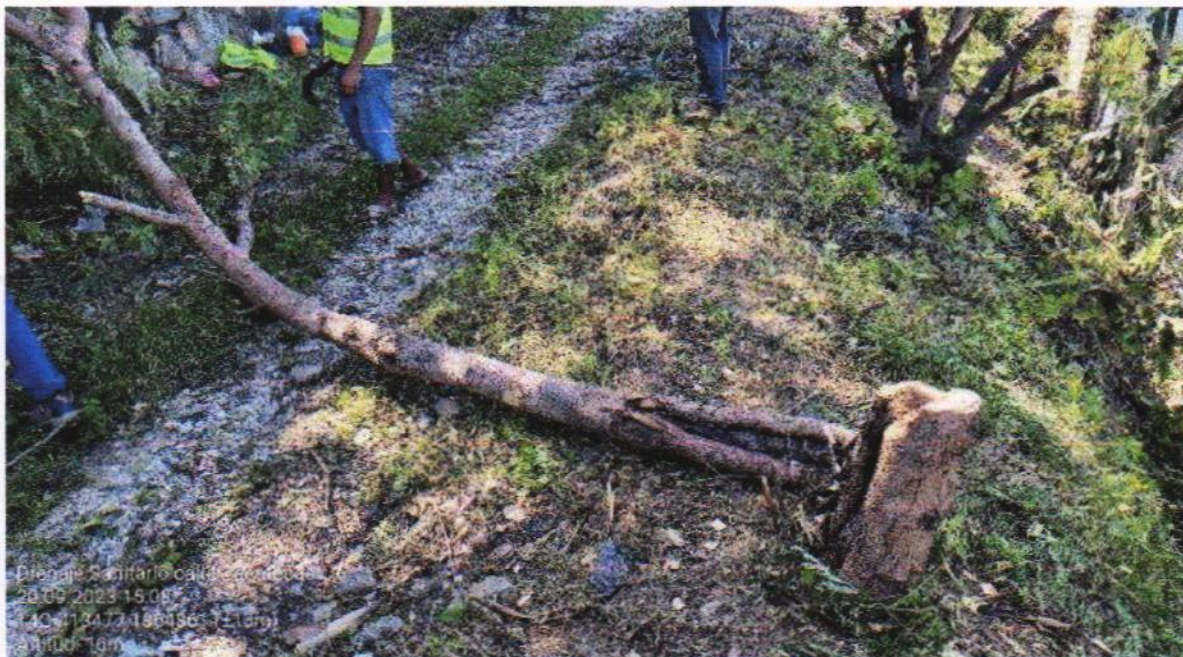
T-DES* TALA Y DESENRAICE DE ARBOL DE HASTA 45 CMS. DE DIAMETRO ,INCLUYE:EQUIPO Y HERRAMIENTA Y MANO DE OBRA.
