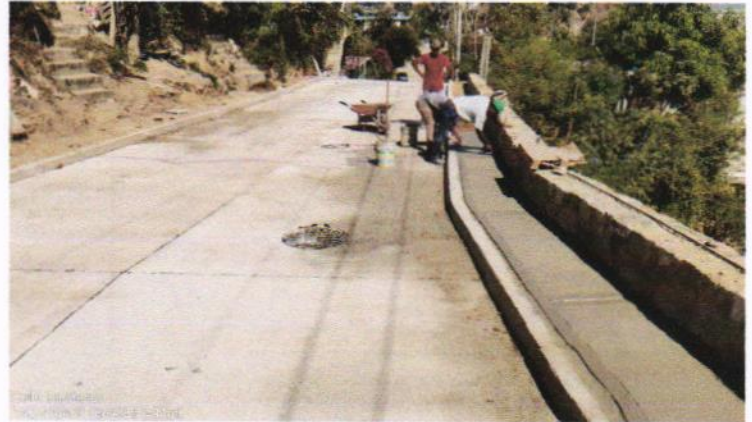
32-0467 BANQUETA DE 10 CMS. DE ESPESOR, CONCRETO HIDRAULICO H.O. DE F'c= 150 KG/cm2, T.A.M. 3/4", ACABADO RAYADO, INCLUYE: CURADO CON CURACRETO ROJO, CIMBRADO, DESCIMBRADO, MATERIAL Y MANO DE OBRA. 16.42M2
