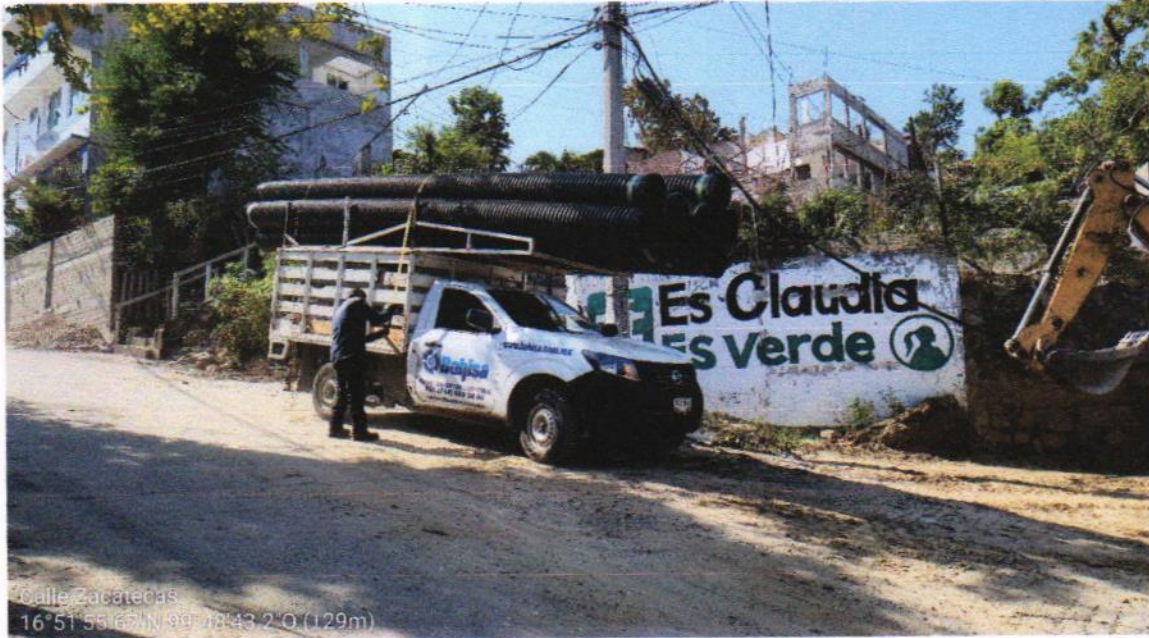
SUM-01 SUMINISTRO Y COLOCACION DE TUBERIA DE POLIETILENO DE 30 CMS DE DIAMETRO , INCLUYE: BAJADO, ALINEADO, COLADO Y ACARREOS A 1ra ESTACION
