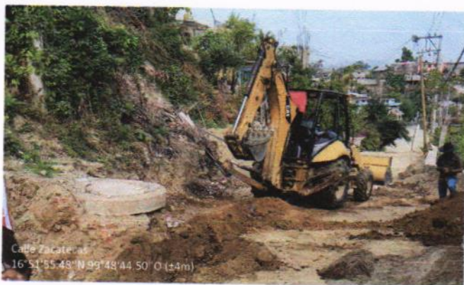
EXCAVACIÓN EN CEPAS PARA RED DE AGUA POTABLE
