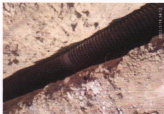
SUM-01 SUMINISTRO Y COLOCACION DE TUBERIA
