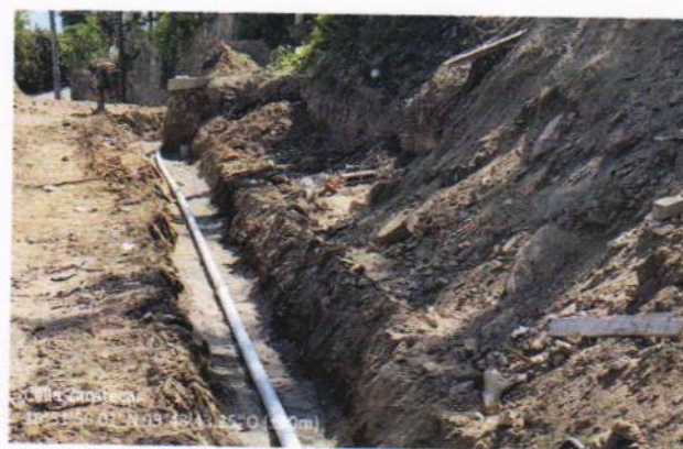
SUMINISTRO Y TENDIDO DE TUBERÍA DE 3" DE PVC CED. RD-26
