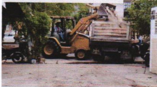
CARGA MECANICA Y ACARREO
