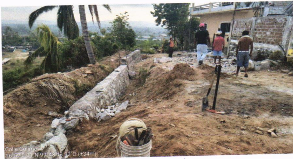
18-0294 MURO DE PIEDRA BRAZA DE LA REGION, ASENTADA CON MORTERO CEMENTO-ARENA 1:3. ACABADO COMUN, INCLUYE: ACARREO DE MATERIALES EN 1ra. ESTACION DE 20.00 MTS.
