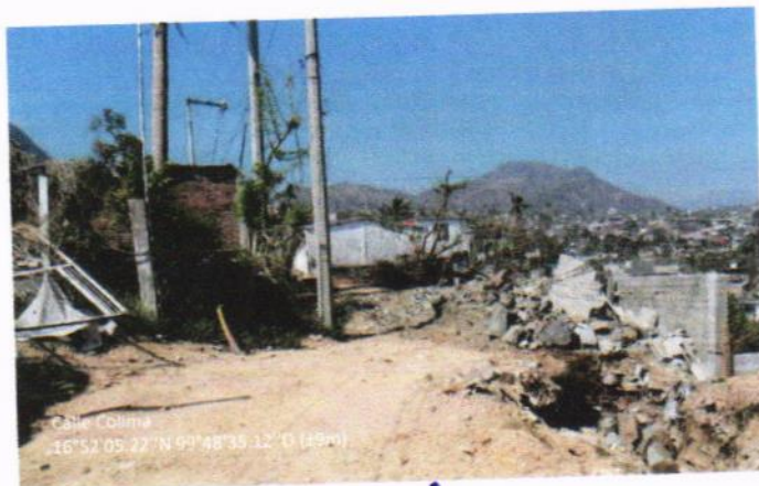
OBRA SIN ACTIVIDAD POR HURACÁN OTIS
