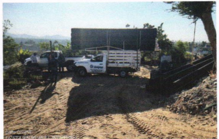
SUM-01 SUMINISTRO Y COLOCACION DE TUBERIA DE POLIETILENO DE 30 CMS DE DIAMETRO , INCLUYE: BAJADO, ALINEADO, COLADO Y ACARREOS A 1ra ESTACION. 2.55ML
