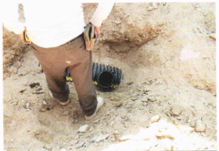
SUM-SILL SUMINISTRO E INSTALACIÓN DE SILLETA DE PVC ESTRUCTURADO ANULAR (NOVAFORTE), PARA ALCANTARILLADO SANITARIO DE 12" X 6" DE DIÁMETRO, INCLUYE: FLETE, CARGA Y DESCARGA AL ALMACÉN DE OBRA, CORTE, LIMPIEZA, LUBRICANTE, PEGAMENTO, ACOPLADO, BAJADO Y ALINEADO. 1.00 PZA
