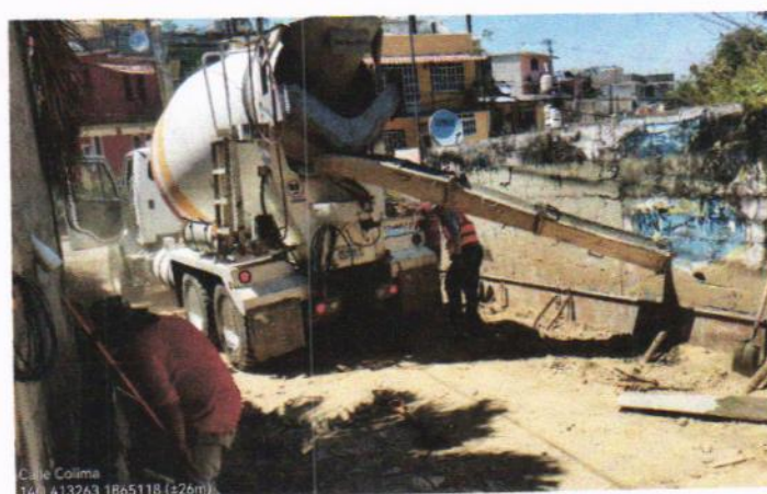
GUARNICIÓN DE CONCRETO F'C=200 KG/CM2
