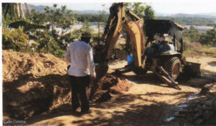
EXCAVACIÓN EN CEPAS PARA RED DE AGUA POTABLE
