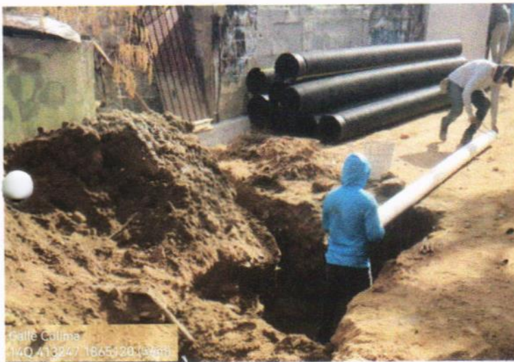
DESC-6" DESCARGA DOMICILIARIA A BASE DE TUBERIA DE P.V.C.DE 6" REXOLI, DE 4.00 ML INCLUYE: EXCAVACIONES, RELLENOS , ACARREO DE MATERIALES EN 1ra. ESTACION. 1.00 SAL
