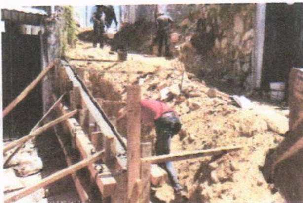
MURO DE CONCRETO ARMADO
