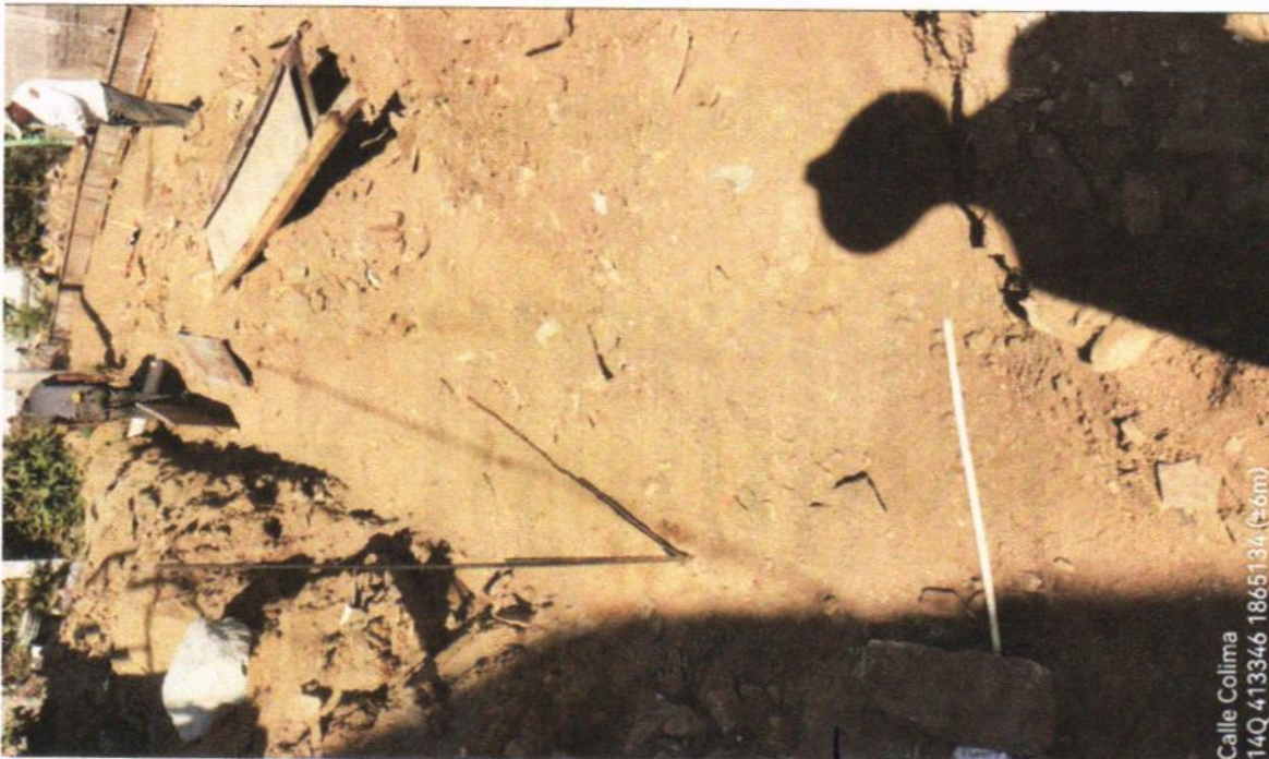
4-0079 EXCAVACION A MANO EN CEPAS DE 0.00 A 2.00 MTS. DE PROFUNDIDAD EN MATERIAL TIPO II, INCLUYE AFINDE DE TALUD Y FONDO.
