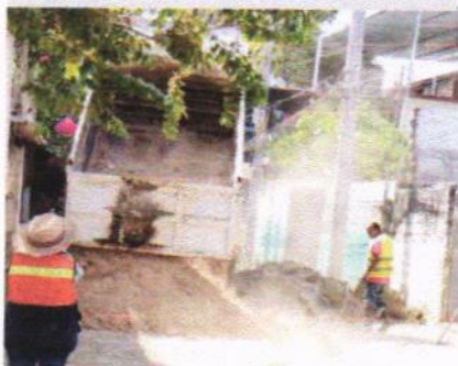
RELLENO DE MATERIAL
