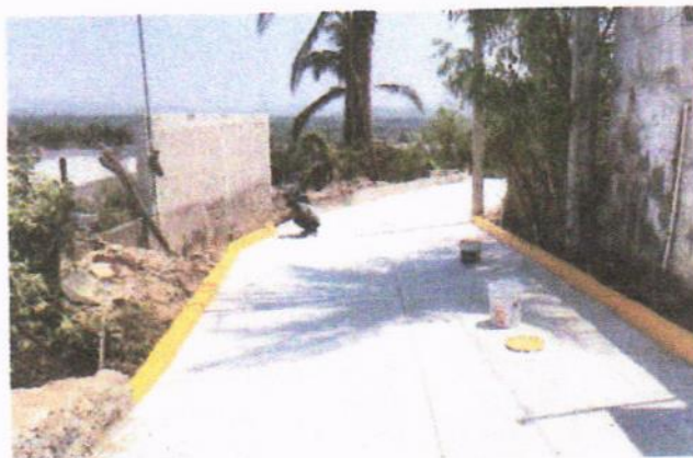
PINTURA DE ESMALTE COLOR AMARILLO EN GUARNICIONES
