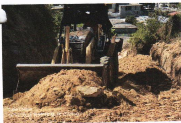
APERTURA EN CAJA POR MEDIOS MECÁNICOS
