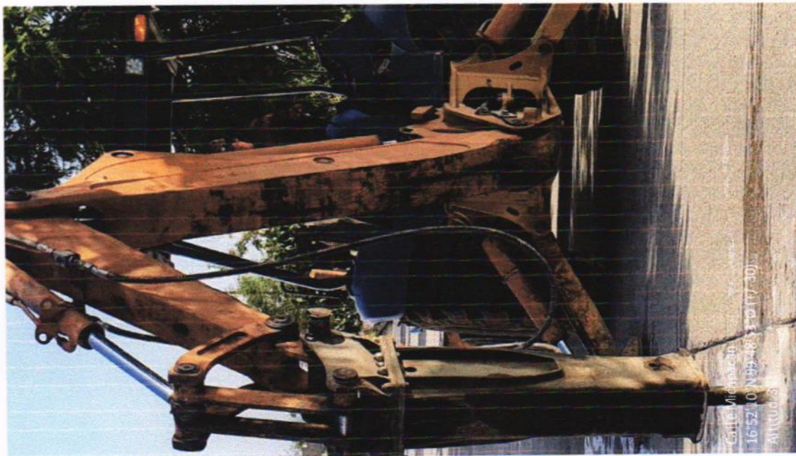
D-0111 DEMOLICION A MAQUINA (ROTOMARTILLO) DE PAVIMENTO DE CONCRETO SIMPLE DE 15 CMS. DE ESPESOR, INCLUYE: ACARREOS EN 1ra ESTACION, LIMPIEZA.
