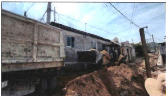
CARGA MECANICA Y ACARREO A TIRO LIBRE EN CAMION
