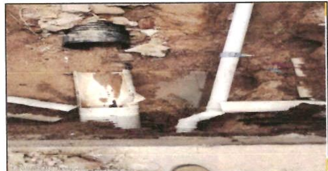
5-0102 CODO P.V.C HIDRAULICO CED. RD-26 DE 3"x45 PARA LINEA DE AGUA POTABLE, INCLUYE: ANILLO EMPAQUE.
