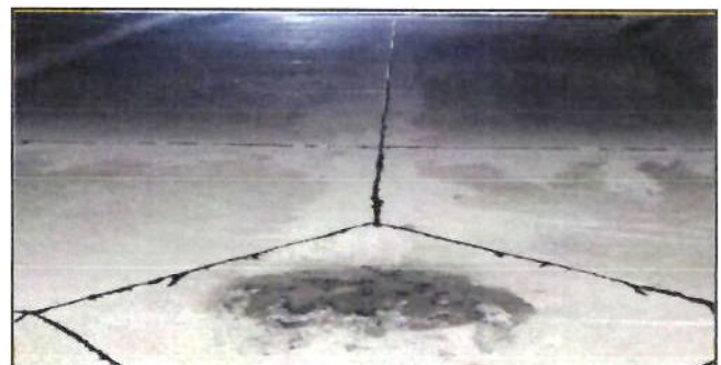
CALAFATEO EN LOSAS A BASE DE ASFALTO
