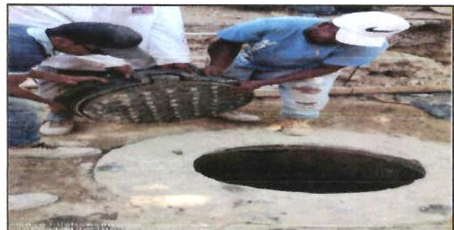
SUMINISTRO Y COLOCACION DE BROCAL DE FIERRO FoFo
