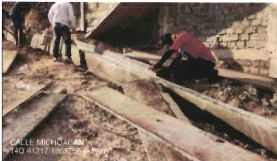
GUARNICION DE CONCRETO F'c= 200 Kg/cm2
