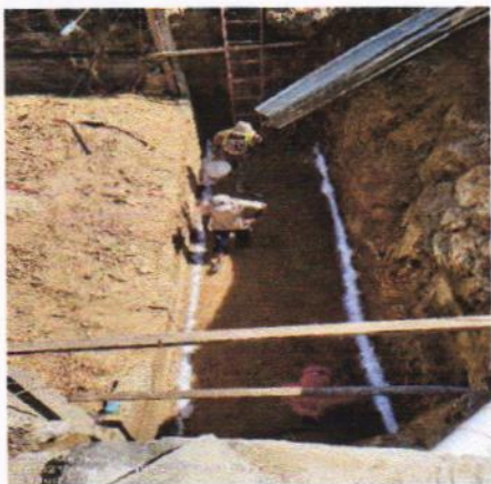
TRAZO Y NIVELACION TOPOGRAFICA DEL TERRENO
