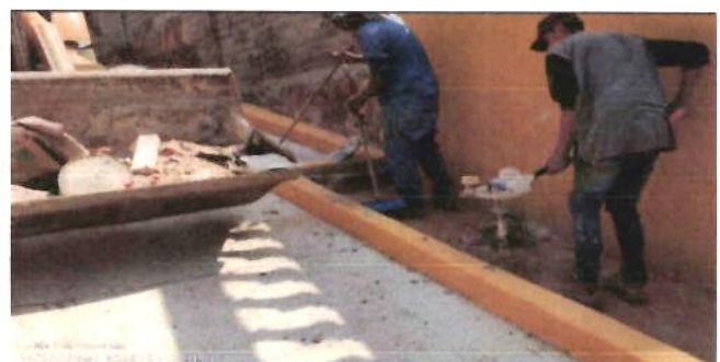
LIMPIEZA ULTIMA GENERAL DE OBRA
