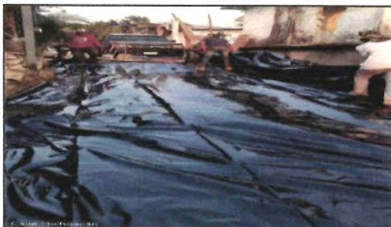
SUMINISTRO Y COLOCACION DE MEMBRANA DE POLIETILENO
