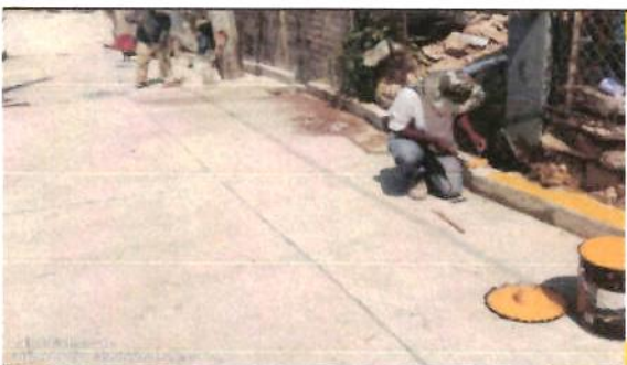
PINTURA ESMALTE AMARILLO TRAFICO EN GUARNICIONES
