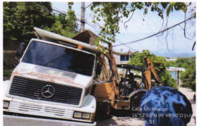
CARGA CARGA MECANICA Y ACARREO A TIRO LIBRE EN CAMION
