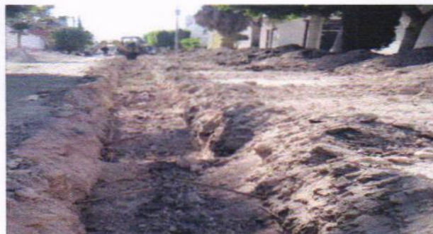
EX-MAT2A EXCAVACION POR MEDIOS MECANICOS EN CEPAS DE 0.00 A 2.00 MTS. DE PROFUNDIDAD EN MATERIAL TIPO II-A ,INCLUYE: AFINE DE TALUD Y FONDO.
