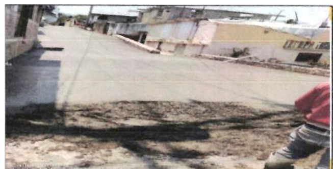
PAVIMENTO PREMEZCLADO F'c= 250 Kg/cm2
