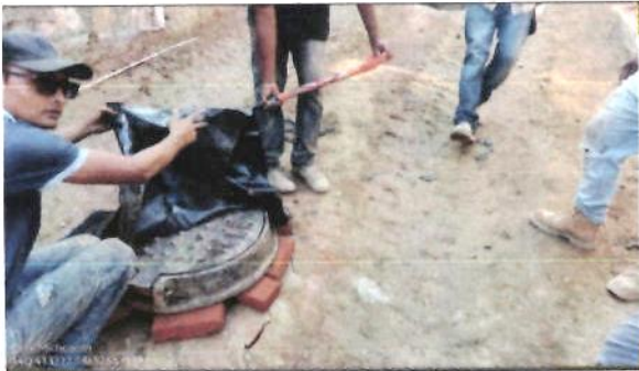
37-0579 SUMINISTRO Y COLOCACION DE BROCAL DE FIERRO FoFo ABIERTO PARA POZO DE VISITA DE 60 cm DE DIAMETRO, DE 135 Kg, INCLUYE: MATERIAL Y MANO DE OBRA.
