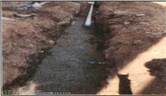
CAMA DE ARENA PARA INSTALACION DE TUBERIA
