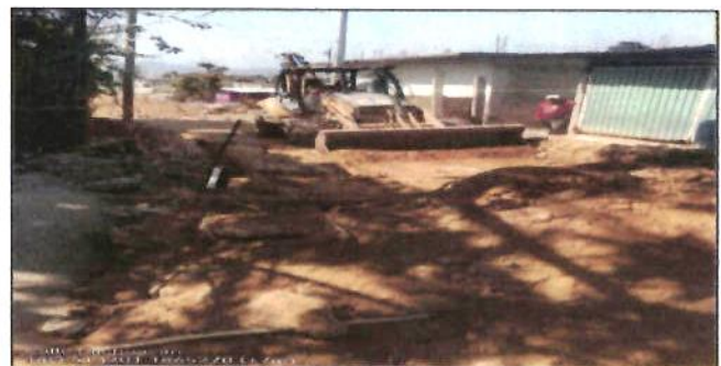
APERTURA EN CAJA POR MEDIOS MECANICOS
