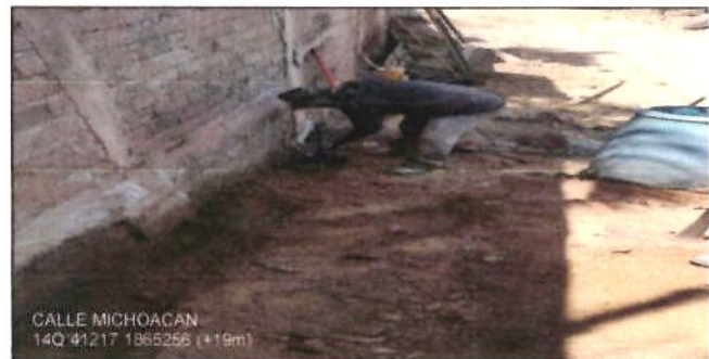
EXCAVACION A MANO EN CEPAS DE 0.00 A 2.00 MTS. DE PROFUNDIDAD EN MATERIAL TIPO II, INCLUYE AFINDE DE TALUD Y FONDO.
