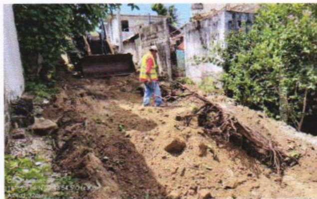
TALA Y DESENRAICE DE ARBOL DE HASTA 45 CMS. DE DIAMETRO
