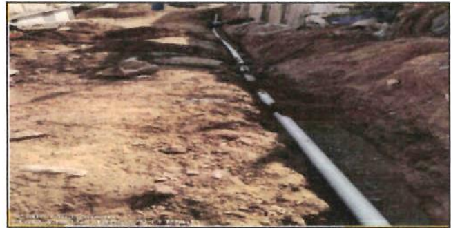
SUMINISTRO Y TENDIDO DE TUBERIA DE P.V.C. 3"
