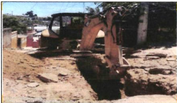
EXCAVACION POR MEDIOS MECANICOS EN CEPAS DE 0.00 A 2.00 MTS. DE PROFUNDIDAD EN MATERIAL TIPO II-A ,INCLUYE: AFINE DE TALUD Y FONDO.
