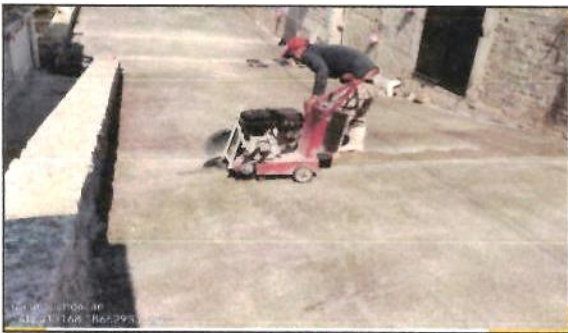
CORTE DE JUNTAS EN PISO DE CONCRETO
