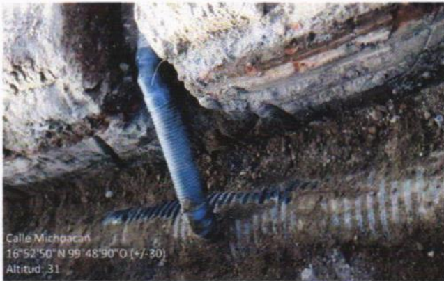
SUMINISTRO E INSTALACIÓN DE SILLETA DE PVC
