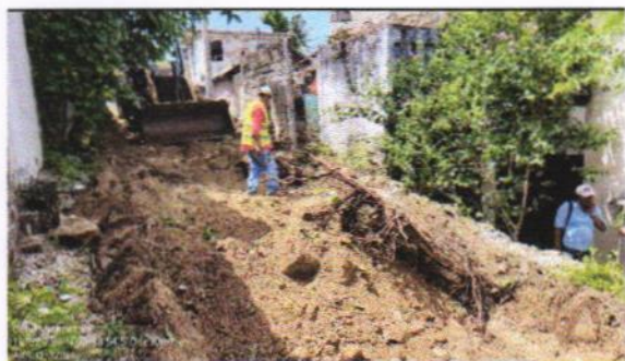
T-DES* TALA Y DESENRAICE DE ARBOL DE HASTA 45 CMS. DE DIAMETRO, INCLUYE: EQUIPO Y HERRAMIENTA Y MANO DE OBRA.
