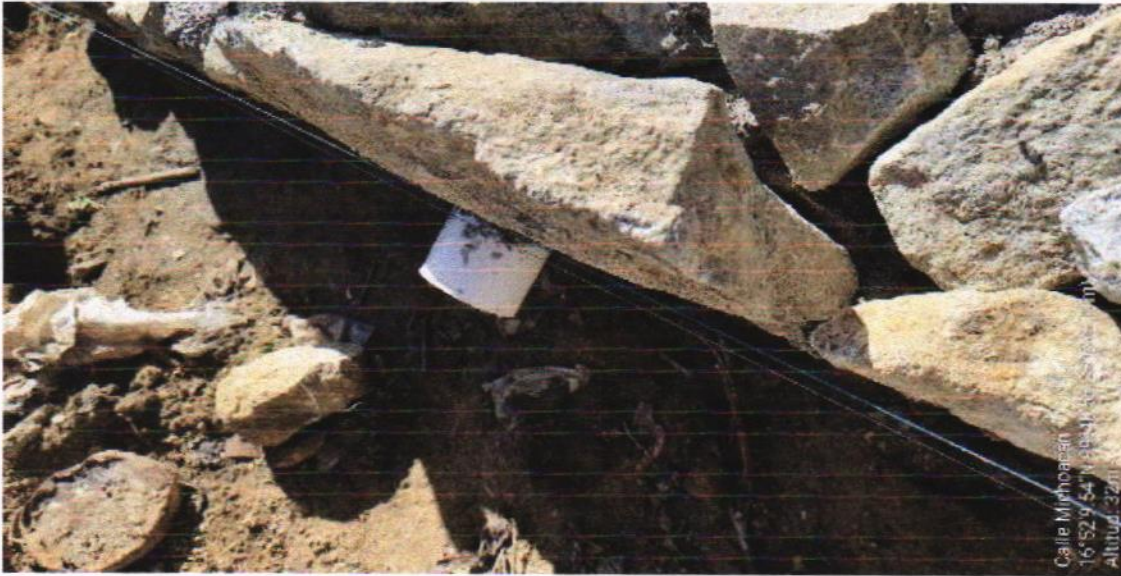
18-0313 DREN PARA MURO DE MAMPOSTERIA A BASE DE P.V.C. 4" TIPO RIGIDO INCLUYE: MATERIAL Y MANO DE OBRA.
