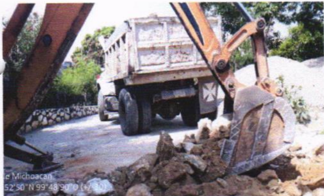
DEMOLICION A MAQUINA (ROTOMARTILLO) DE PAVIMENTO
