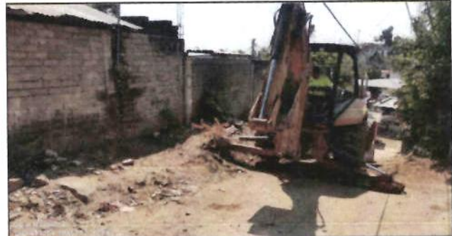
EX-MAT2A EXCAVACION POR MEDIOS MECANICOS EN CEPAS DE 0.00 A 2.00 MTS. DE PROFUNDIDAD EN MATERIAL TIPO II-A ,INCLUYE: AFINE DE TALUD Y FONDO.
