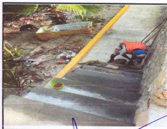
FORMADO DE ESCALON
