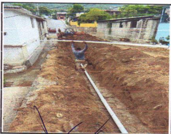
SUMINISTRO DE TUBERIA
