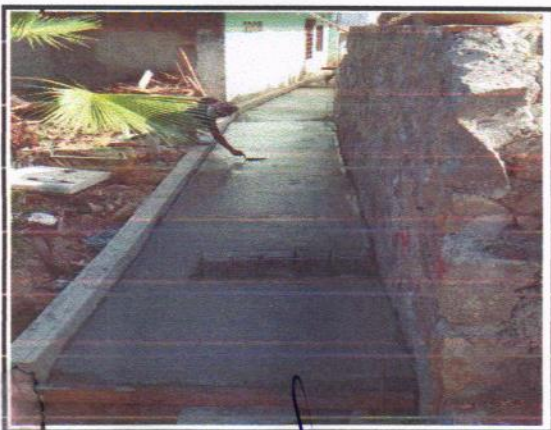
PAVIMENTO PREMEZCLADO EN ANDADORES
