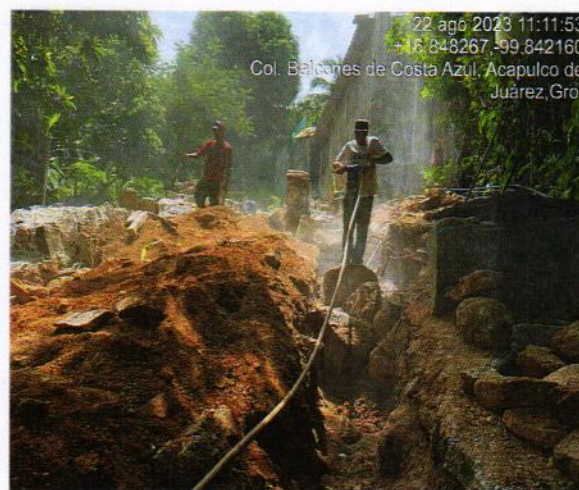
BARRENADO Y DEMOLICIÓN DE ROCA
