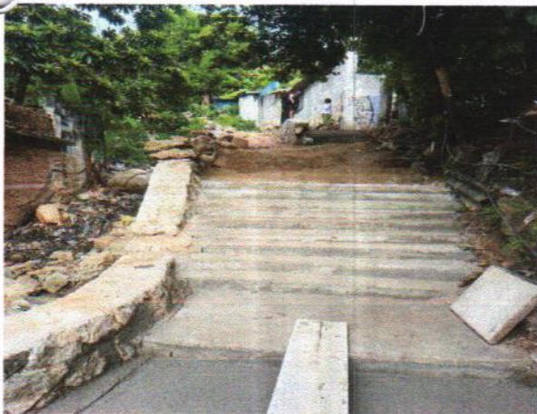
PISO DE CONCRETO
