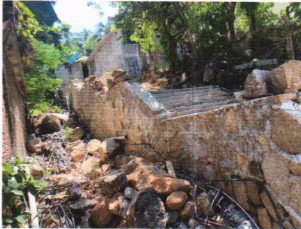
CONSTRUCCION DE MURO
