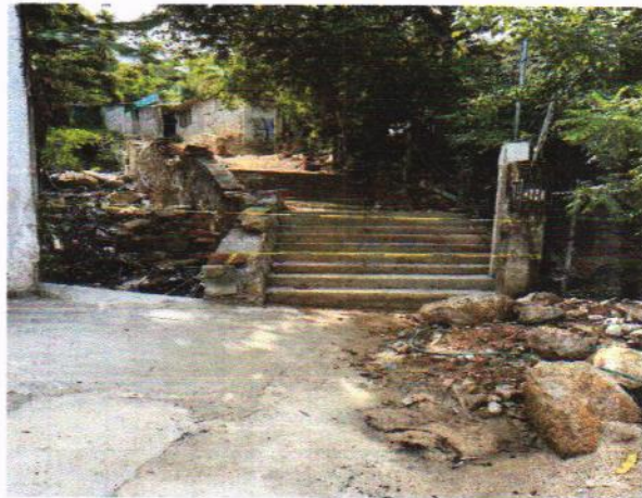
CONSTRUCCION DE ESCALONES
