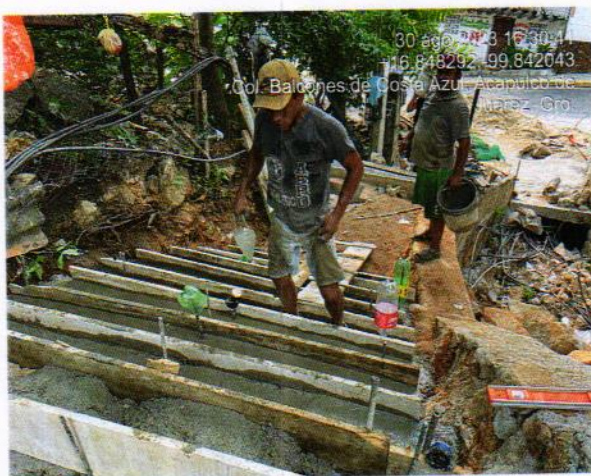
CONSTRUCCIÓN DE ESCALONES
