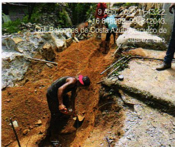
RELLENO MATERIAL DE BANCO
