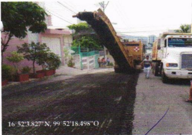
FRESADO DE CARPETA EXISTENTE
