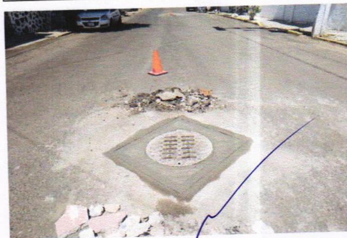
RENIVELACION DE POZO DE VISITA A BASE DE CONCRETO
