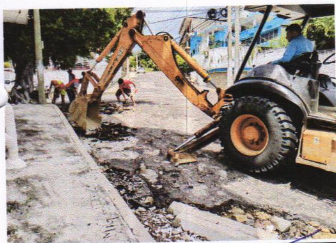
EXCAVACION POR MEDIOS MECANICOS
