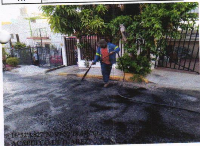
RIEGO DE LIGA CON EMULSION ASFALTICA
