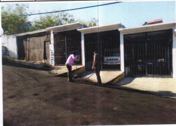
LIMPIEZA GENERAL DURANTE LA OBRA
