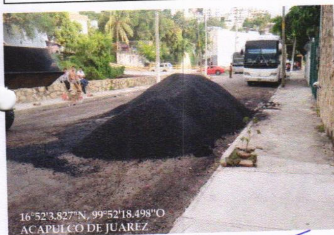
ACARREO DE MEZCLA ASFALTICA
