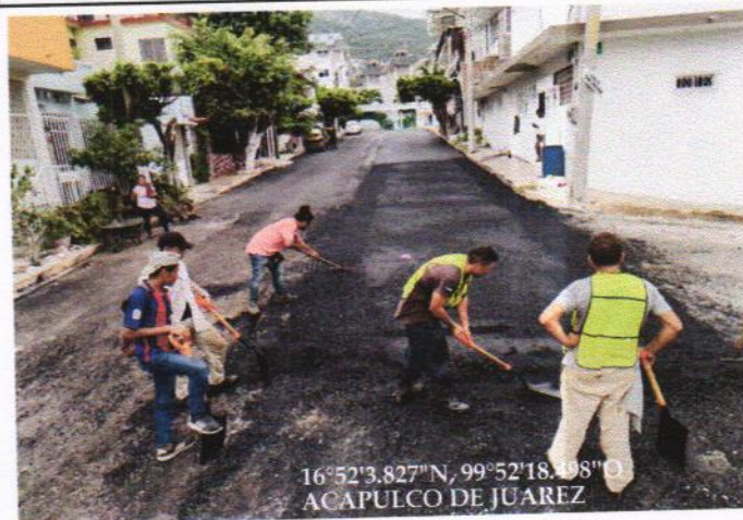
CARPETA ASFALTICA DE 5.00 DE ESPESOR
