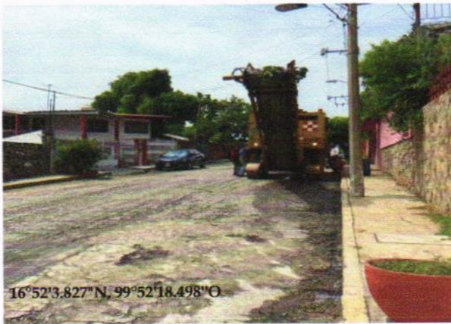
FRESADO DE CARPETA EXISTENTE
