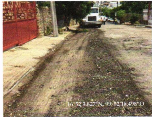
FRESADO DE CARPETA EXISTENTE
