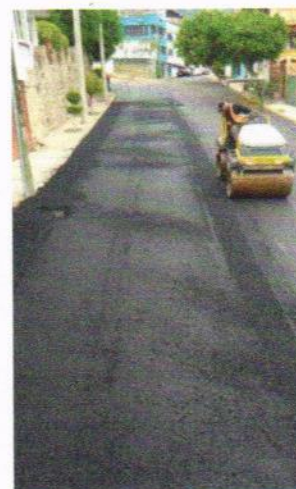
CARPETA ASFÁLTICA DE 5 CM DE ESPESOR
