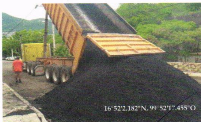
CARPETA ASFÁLTICA DE 5 CM DE ESPESOR
