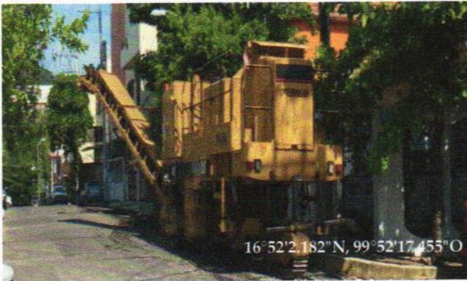
FRESADO DE CARPETA EXISTENTE
