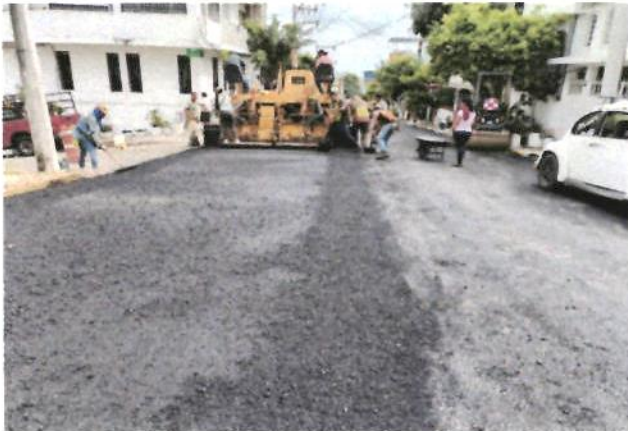
CARPETA ASFALTICA DE 5 CM. DE ESPESOR
