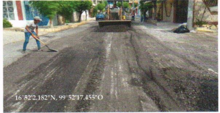
FRESADO DE CARPETA EXISTENTE
