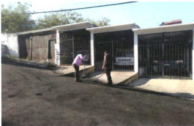
LIMPIEZA GENERAL DE OBRA
