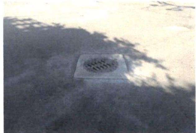
RENIVELACION DE POZOS DE VISITA
