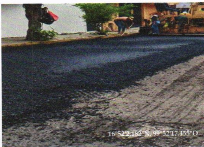
CARPETA ASFÁLTICA DE 5 CM DE ESPESOR
