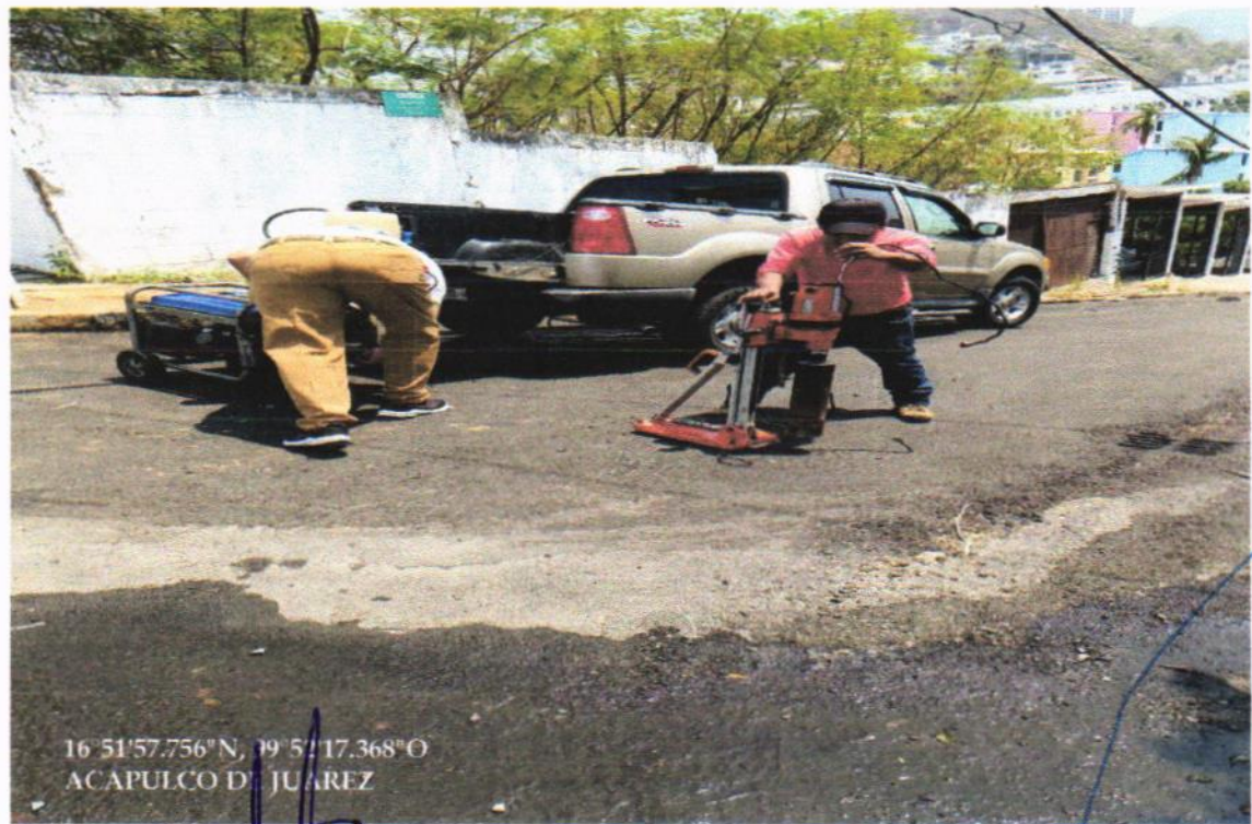
PRUEBAS DE COMPACTACIÓN
