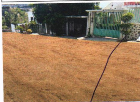
FORMACION DE BASE DE 20 CMS. DE ESPESOR
