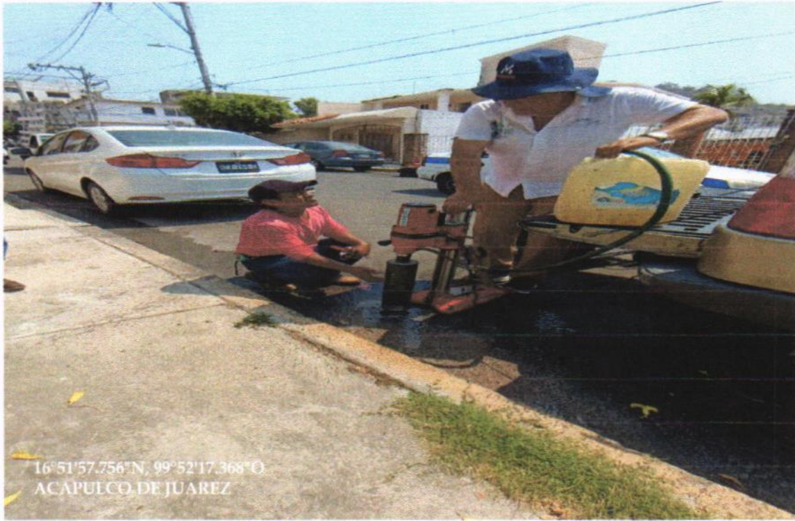
PRUEBAS DE COMPACTACIÓN
