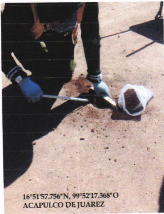
COMPACTACIÓN DE BASE
