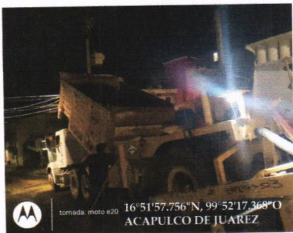
ACARREO DE MEZCLA ASFALTICA
