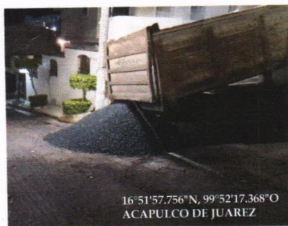
ACARREO DE MEZCLA ASFALTICA
