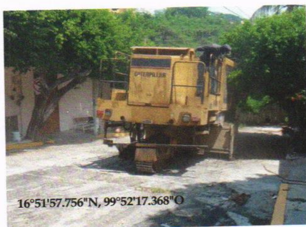
FRESADO DE CARPETA EXISTENTE
