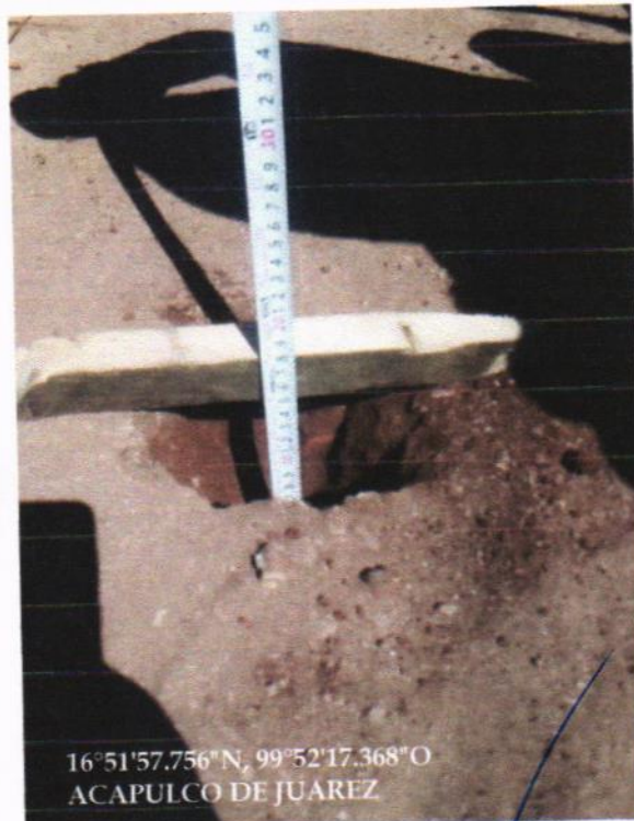
COMPACTACIÓN DE BASE
