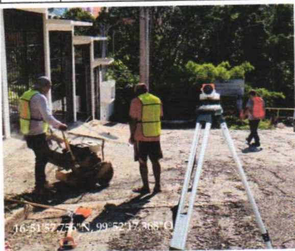
TRAZO Y NIVELACIÓN TOPOGRÁFICA DEL TERRENO
