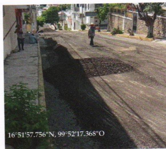
FRESADO DE CARPETA EXISTENTE
